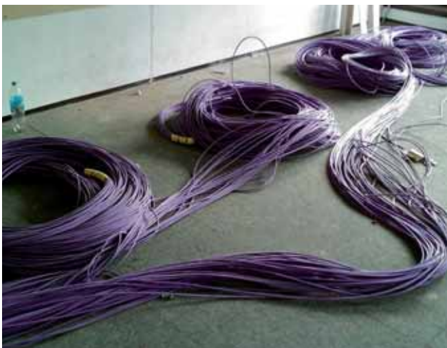
Zuerst werden Datenkabel auf dem Boden auf Länge gebracht, ...
