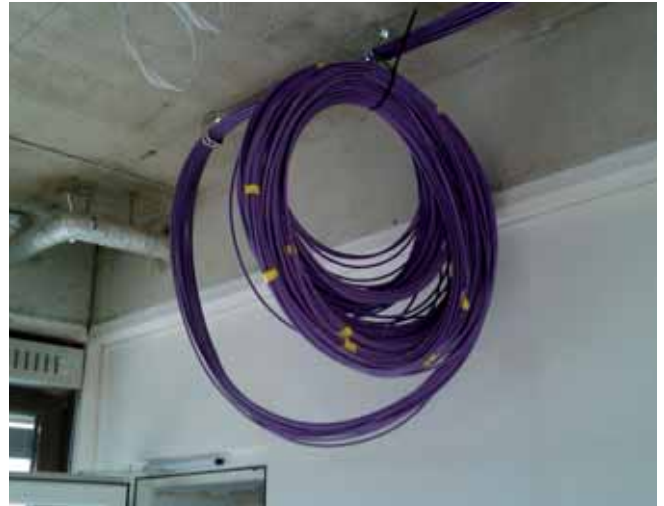
... bevor sie unter der Decke verlegt werden.
