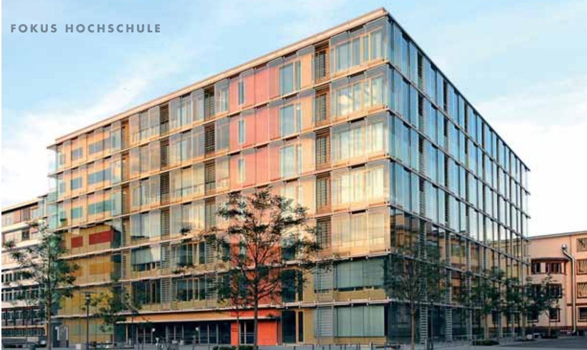
Das Gebäude 1 der FH FFM ist eine von 40 Landesliegenschaften, die am „Energie Cup Hessen“ teilnehmen.
