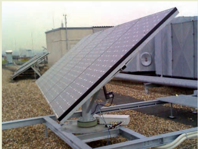
Die Solaranlage auf dem Dach von Gebäude 4
