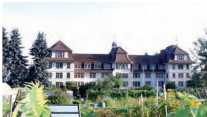
Seit 2007 gehört das historische Gebäude Stella Maris – hoch über dem Bodensee – zur Pädagogischen Hochschule des Kantons St. Gallen in Rorschach. Früher war es eine katholische Haushaltsschule, ein sogenanntes Töchterinstitut.
