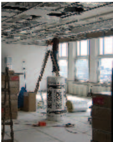
Sommer 2007 - die Bauarbeiten sind im Zeitplan.
