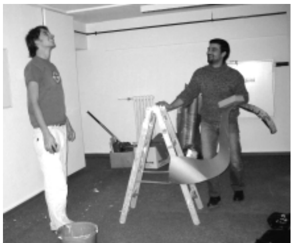
fraLine-Mitarbeiter beim Renovieren der neuen Räume
