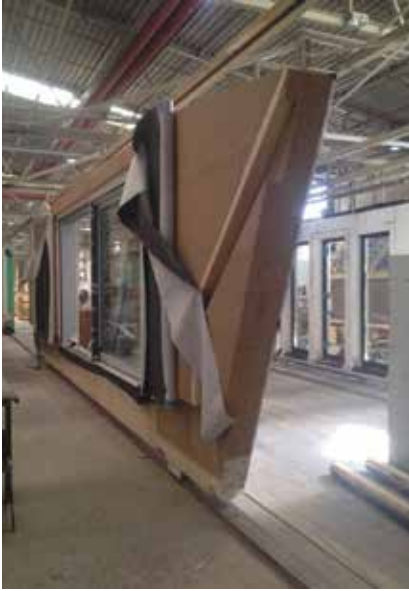
Wand zur Terrasse in der Fertigungsstraße
