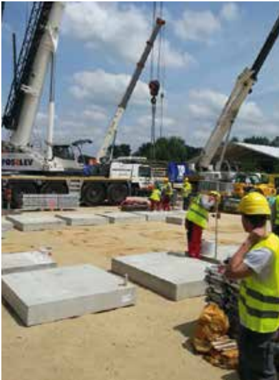
Auslegen des Fundamentes und Einmessen der Höhen
