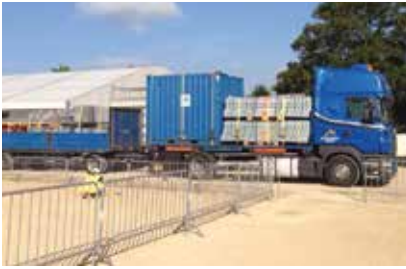
Ankunft des ersten LKWs mit dem Gerüst und der Baustelleneinrichtung
