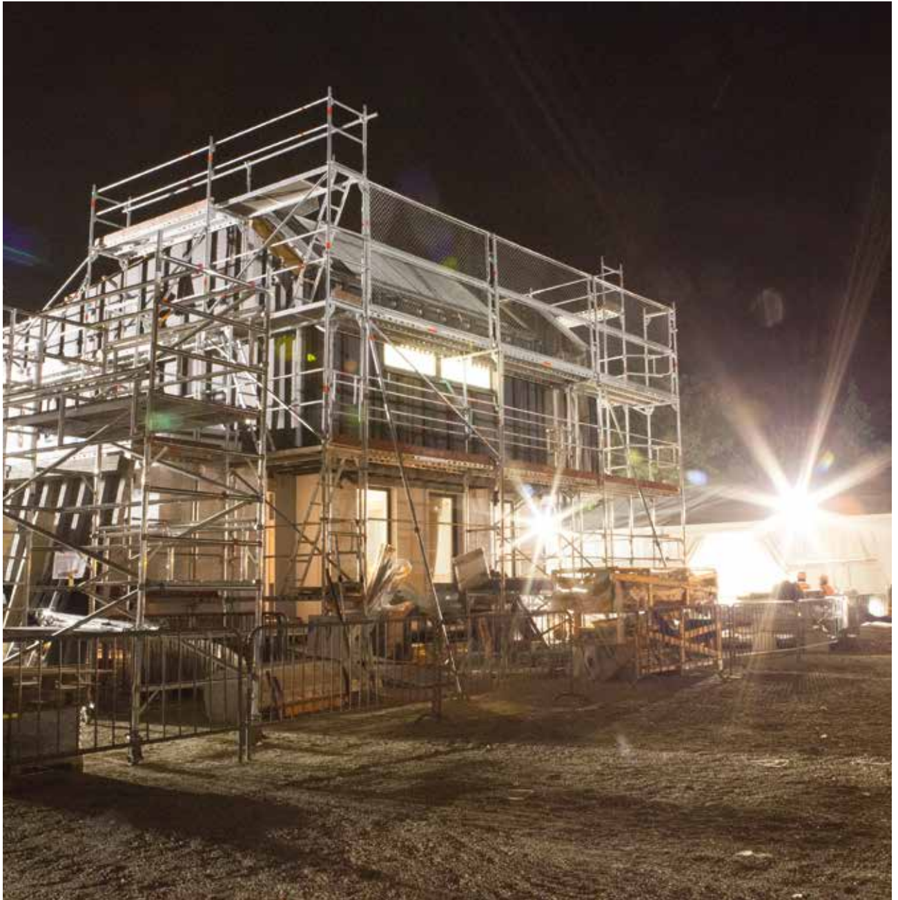
Fertigstellen des Rohbaus in der Nachtschicht
