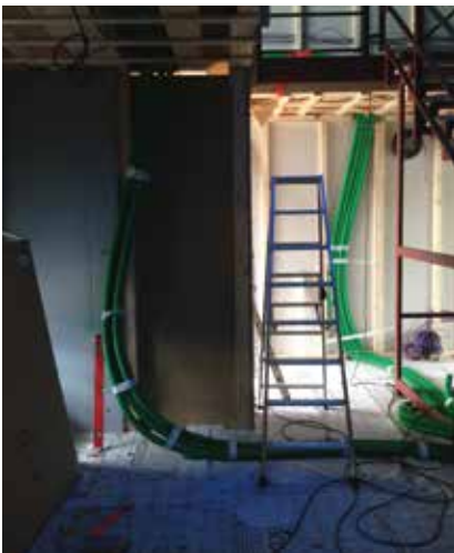
Beginn des Innenbaus mit Rohr- und Kabelverlegen
