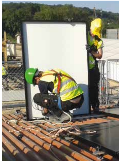
Montage der PV-Anlage
