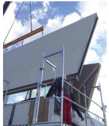
Aufsetzen der Obergeschosswände mithilfe des Kranes
