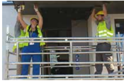
Montage der Fassade
