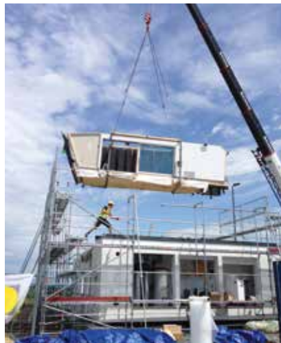
Aufsetzen der Terrasse
