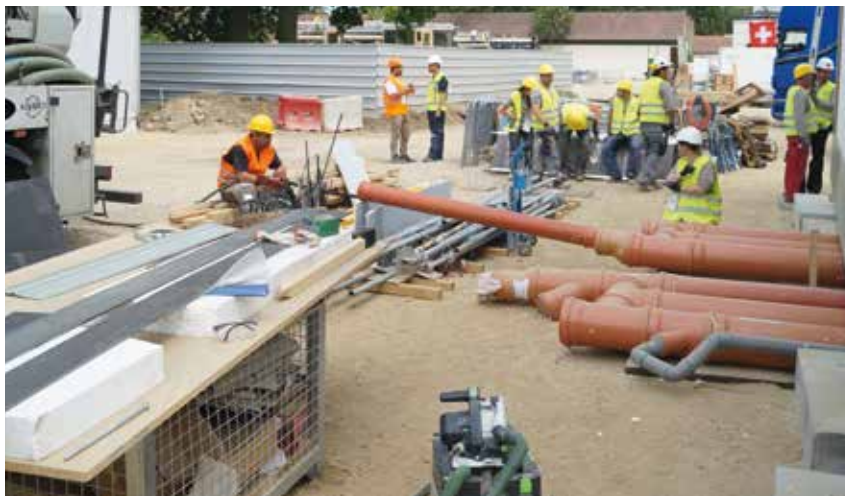
Befülllinks des Frischwassertanks in Versailles
