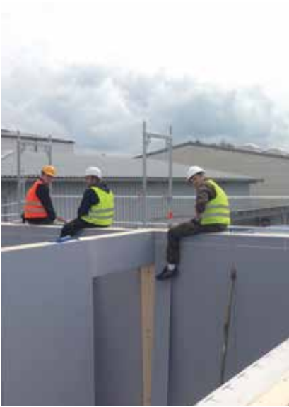
Aufstellen der Erdgeschosswände
