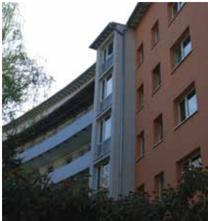
Südansicht des Bestandsgebäudes
