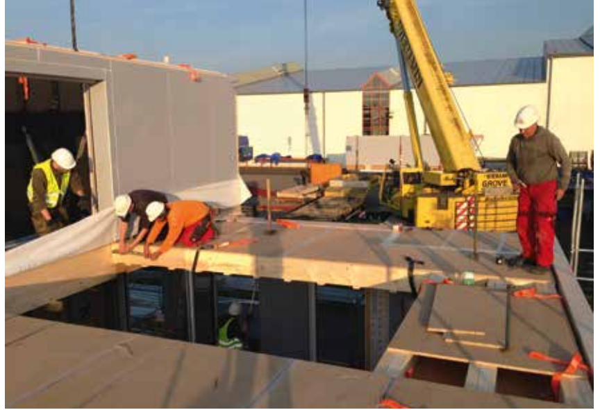
Einsetzen der Deckenelemente
