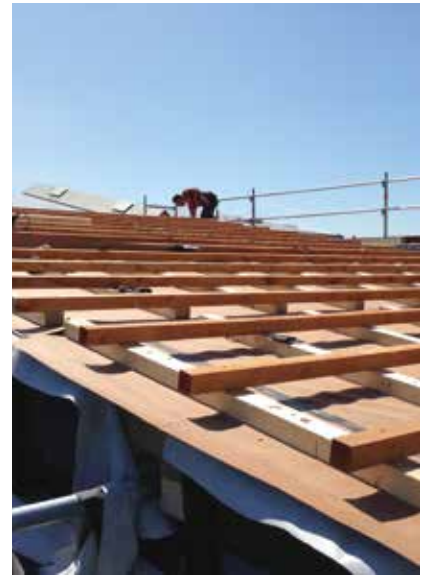
Montage der Dachelemente mit Unterkonstruktion für die Dachhaut
