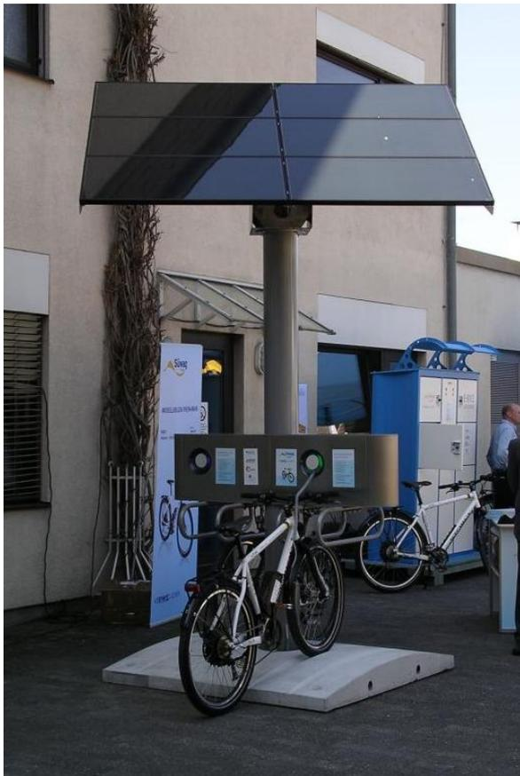
**Abbildung 89:** Photovoltaik-Ladesäule für Pedelecs in Idstein (Klima-Bündnis 2010)
