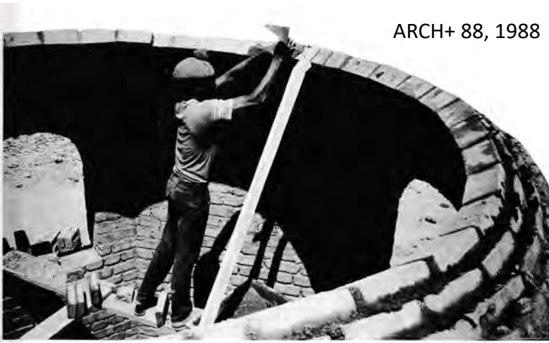
Kuppelbau ohne Schalung
