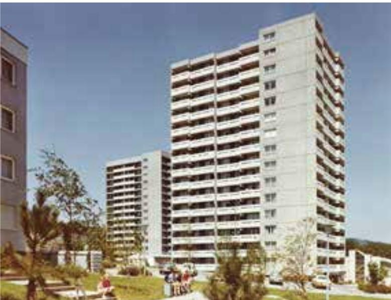
Die Hochhäuser am Ausgang der Siedlung sind aus Waschbetongroßtafeln mit glatten, hellen Balkonbrüstungen gefertigt.
